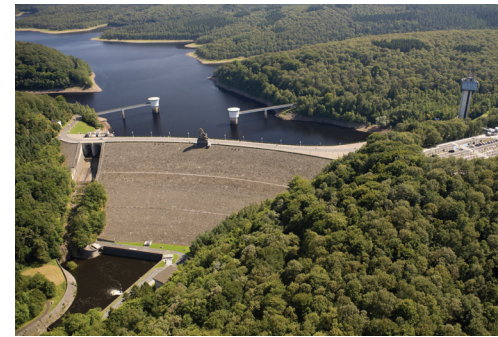
Le barrage de La Gileppe
